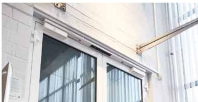
Sicherheitseinrichtungen an Rauch- und Feuerschutztüren. Bildbeispiel: Feststellanlage nach EN 1155, Türschliebersystem: Dorma.
