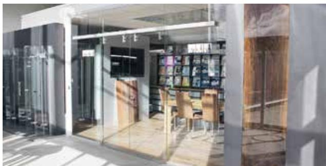
Automatiktür-Sonderausführungen als Ganzglasanlage. Bildbeispiel: zweiflügelige automatische Schiebetür in Ganzglasausführung aus ESG Float 10 mm mit Seitenteil und Oberlicht, Antrieb Dorma CS 80 Magneo.
