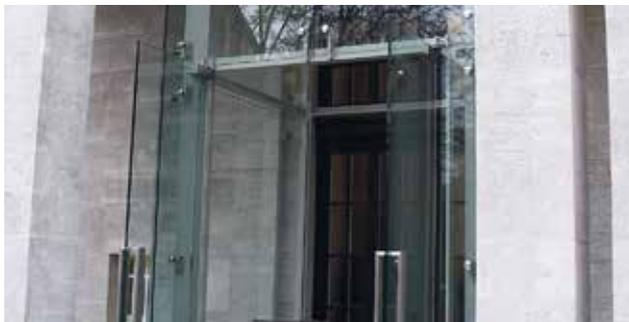
Individuelle Stahl-, Glas- und Sonderkonstruktionen nach Maß wie z. B. Glastreppen, Glasbrücken, Windfänge, Portalanlagen u. v. m. Bildbeispiel: Stahl-Glaskonstruktion mit Ganzglastüren. Sonderbeschläge mit hoher Tragkraft. Punkthalter mit allgemeiner bauaufsichtlicher Zulassung (AbZ).
