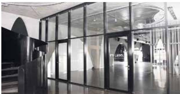
Brandschutztüren und Fassaden nach DIN 4102 mit Fremdüberwachung für alle Brandschutzelemente. Bildbeispiel: System Hueck BSC Tür und Brandschutzfassade.
