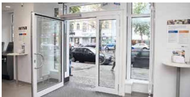
Lösungen für barrierefreie Eingangsanlagen. Bildbeispiel: Drehflügel-Türantrieb auf der Bandseite mit Gleitschiene und Sicherheits-Sensorleisten.
