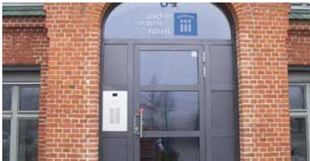
Gedämmte und ungedämmte Aluminiumtüren mit maßgenauen gebogenen und/oder geraden Profilen. Bildbeispiel: Beispiel einer Eingangsanlage für die Renovierung eines historischen Gebäudes, thermisch getrennte Türanlage.
